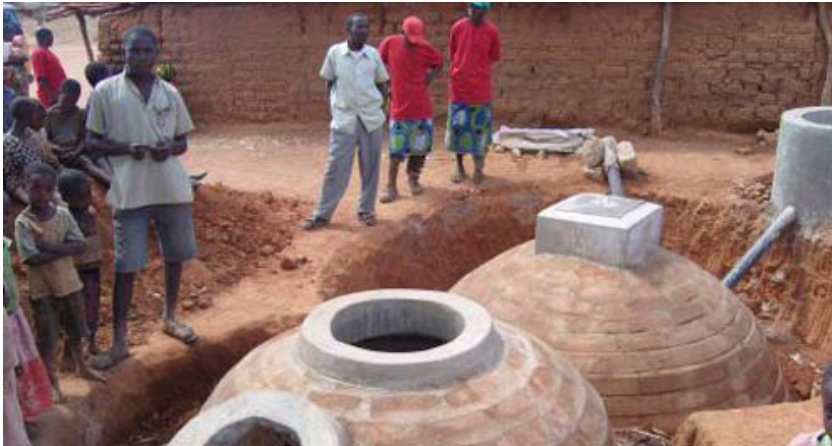
Figura 1: Arriba- Diseño típico de un biodigestor de domo fijo con doble cámara, (Modelo CAMARTEC, Tanzania) . Abajo-biodigestor CAMARTEC construido, previo a ser tapado con tierra (CAMARTEC, Tanzania)
