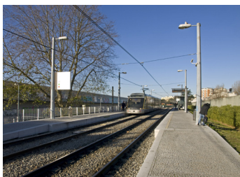
1. Estación Ferroviária Da Lapa
