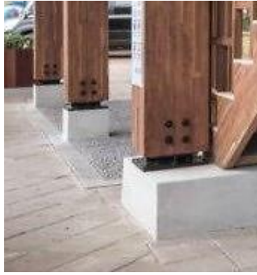
Figura 20-2. Ensamble de columna de madera de Warak Kayu
