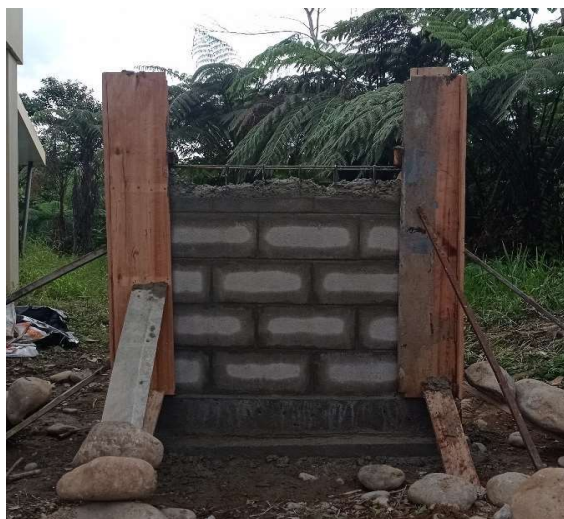
Imagen 7. Proceso constructivo del muro donde fueron aplicadas las pastas en estudio. Realizado por: Jesús March, 2022.
