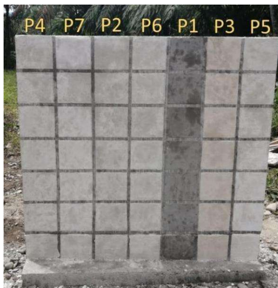
Imagen 9. Muro experimental después de la aplicación de las pastas, Cara A. Realizado por: Jesús March, 2022
