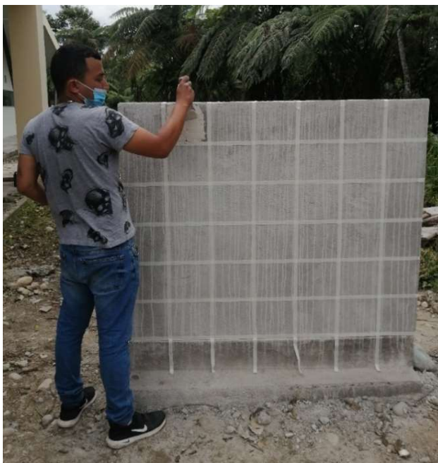
Imagen 8. Aplicación de las pastas de revestimiento elaboradas, en el muro control. Realizado por: Jesús March, 2022.
