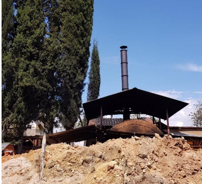
Figura 3-2: Fábrica de ladrillos y tejas artesanales en el sector de Sinincay, Cuenca, Ecuador.
