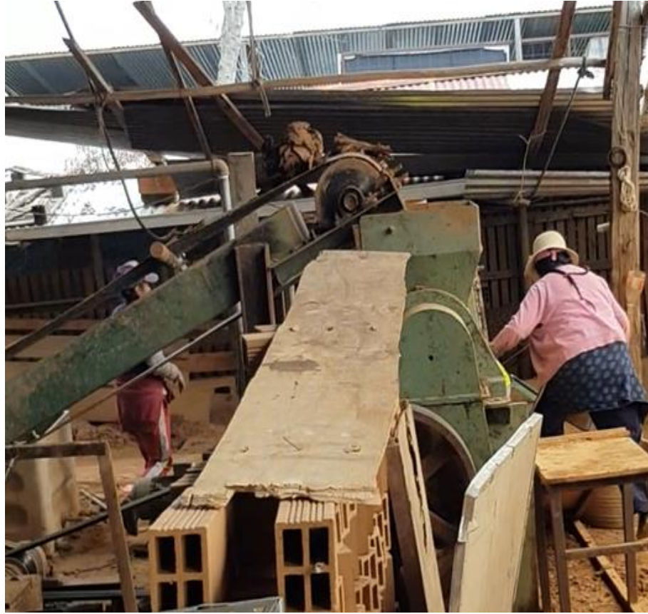
Figura 5-3: La extrusión de la mezcla (en el proceso semi industrial) se produce por medio de máquinas que funcionan a diésel.
