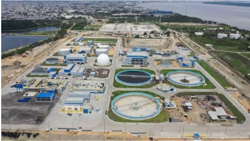
Figura 52: PTAR convencional para las aguas residuales
