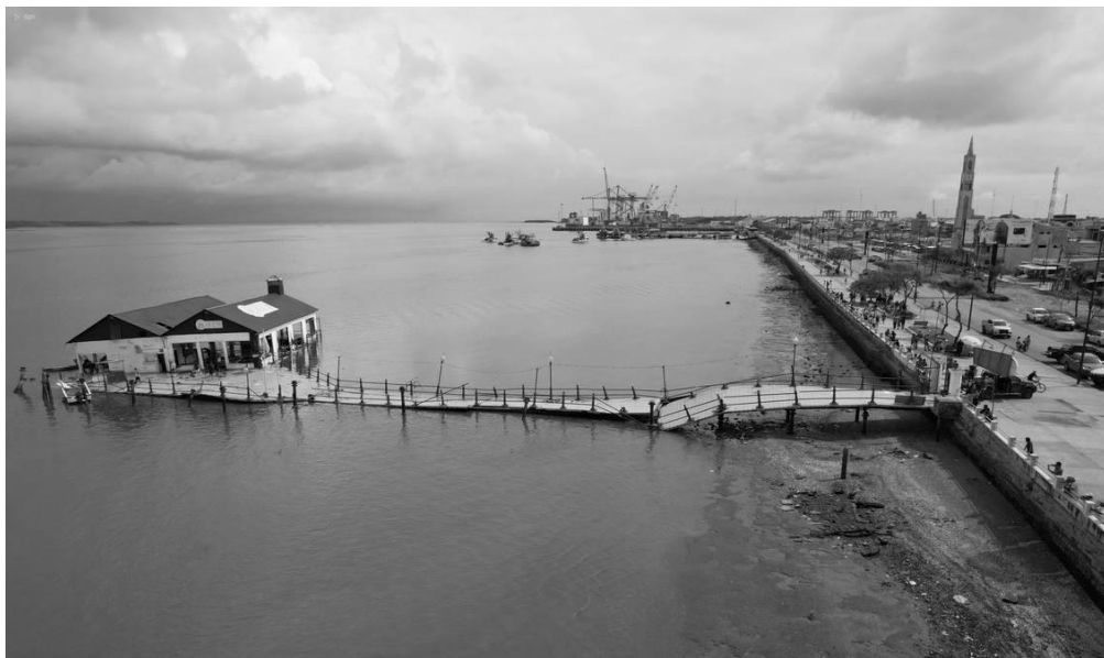
Figura 12: Muelle de Cabotaje de Puerto Bolívar Realizado por: El Universo
