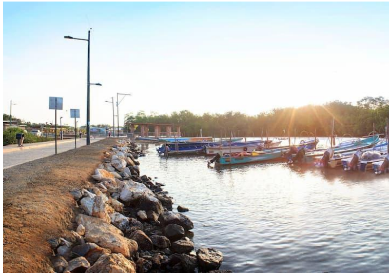
Figura 47: Puerto Hualtaco Realizado por: Ministerio de transporte y obras públicas
