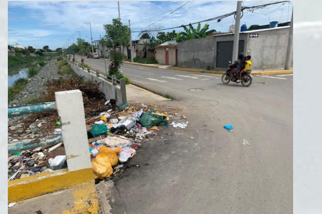
Canal no se integra a la ciudad
