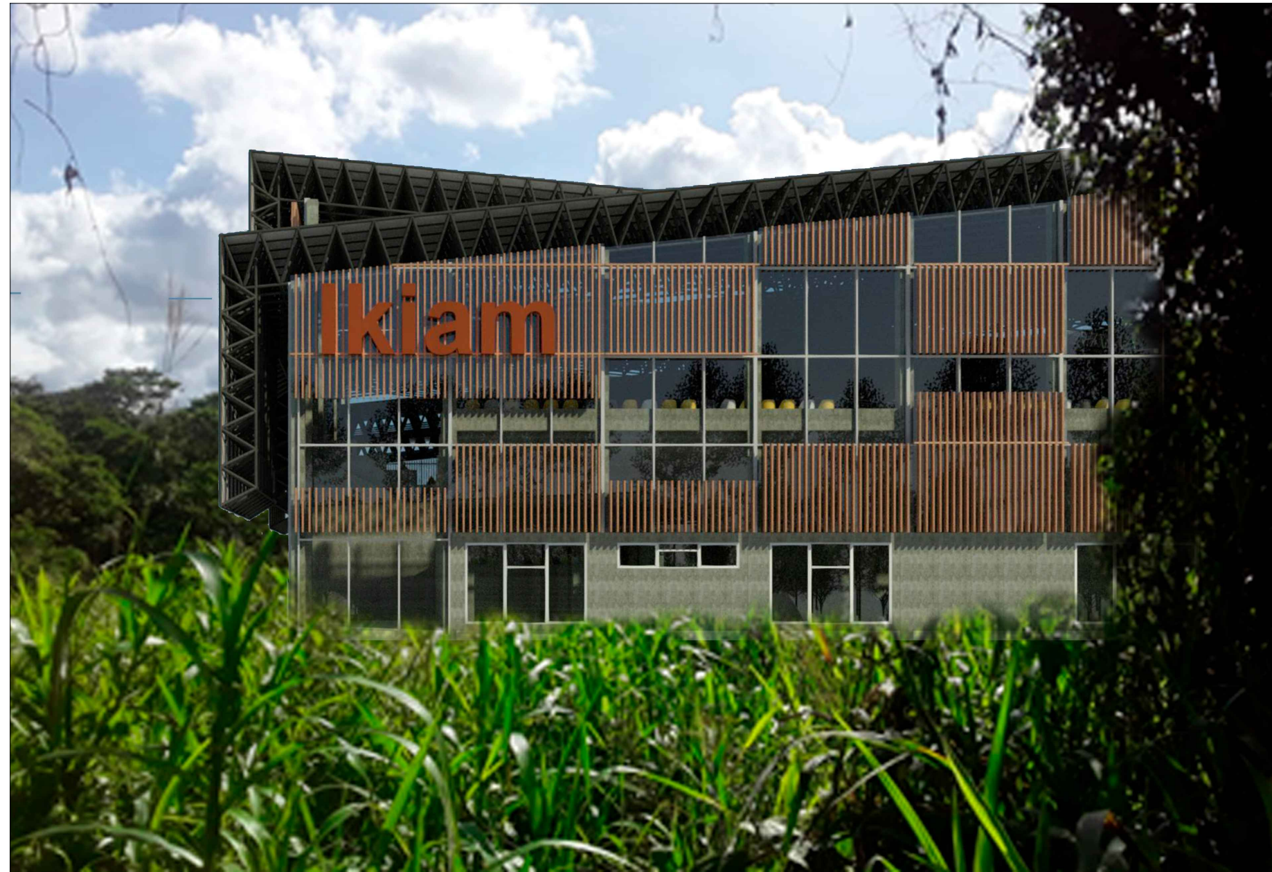
VISTA FRONTAL DEL ACCESO AL COLISEO
