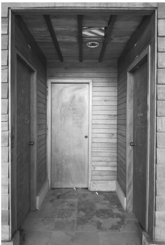
Figura 10. Bloque de tiendas y servicios higiénicos permanecen cerrados Fuente: archivo de los autores
