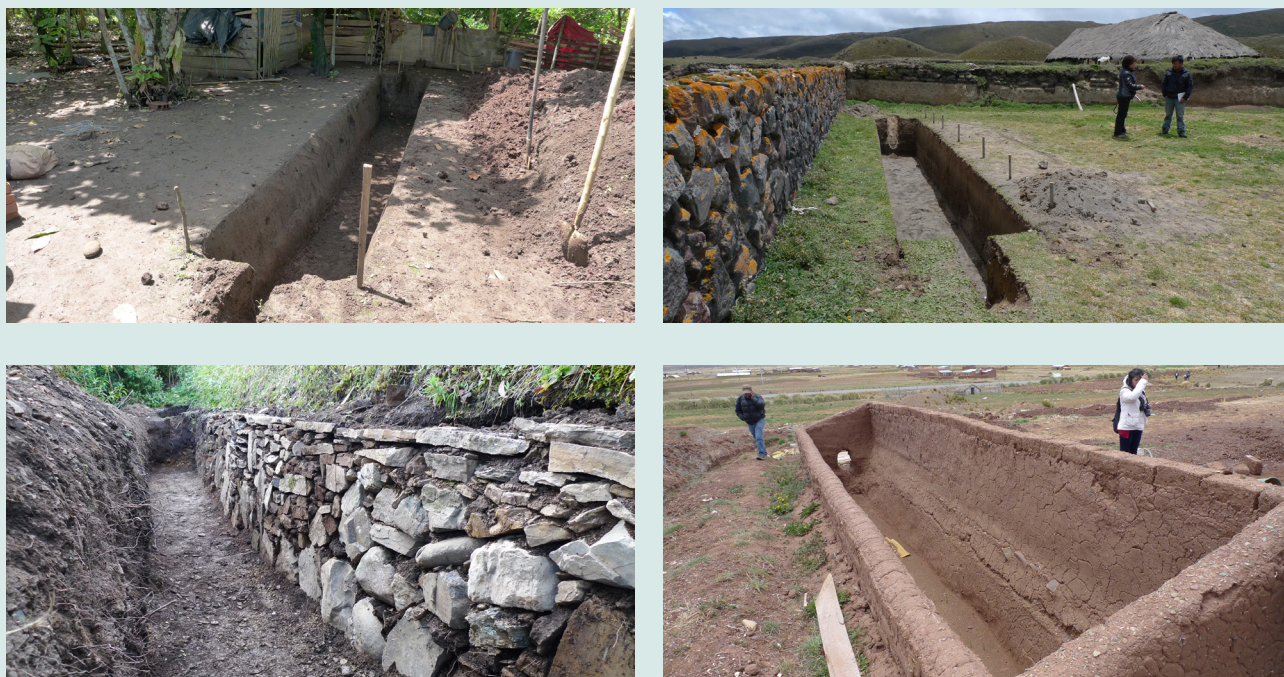
Figura 10: Ejemplos de zanjas para biodigestores tubulares.
