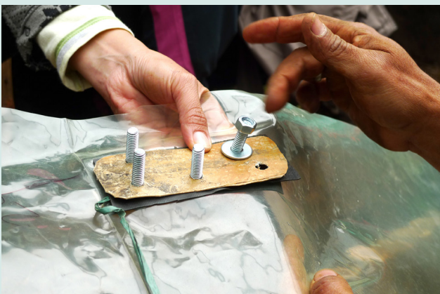
Figura 25: Secuencia fotográfica simulando la reparación “a la colombiana” de un hueco en un biodigestor tubular de plástico de invernadero, usando dos láminas de PVC, dos empaques, tornillos y tuercas.
