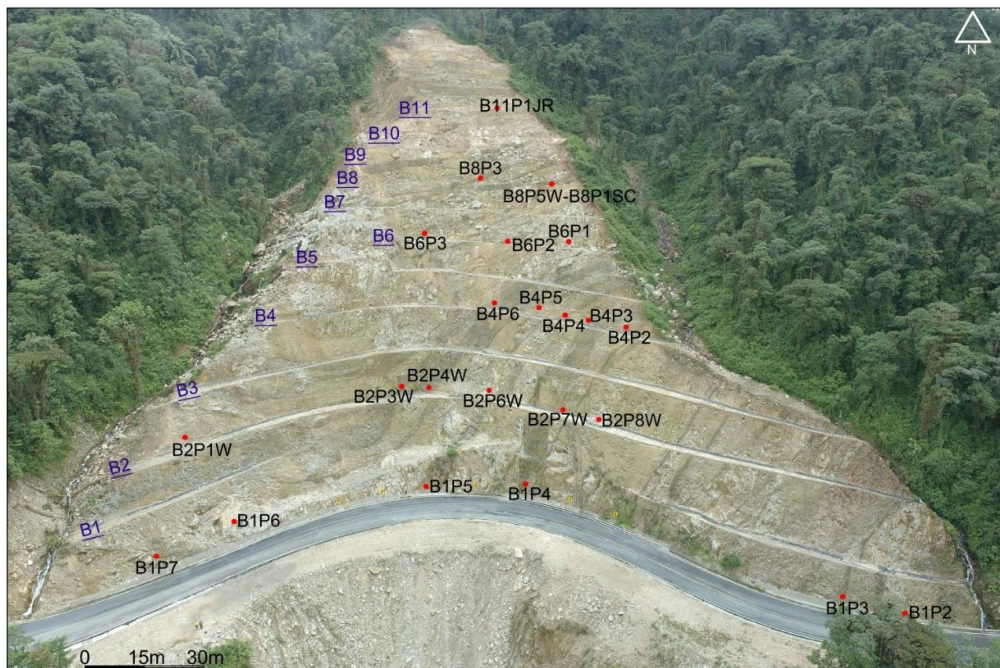
Figura 2-1: Geosítio Shunku Rumi . Fotografía del afloramiento estudiado. Realizado por: Saida Huatoca
