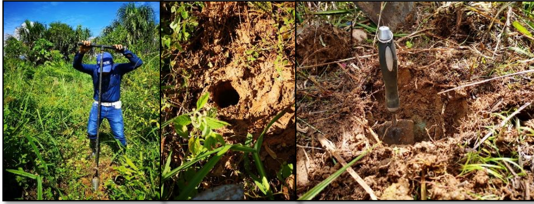
Figura 5. Realización de calicatas.
