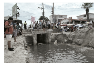
Drenaje de aguas pluviales
