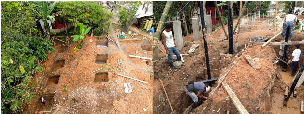
Figura 62. Proceso constructivo de la cimentación de la torre del Napo Wildlife Center. Fuente: Archivo BAQ, 2016
