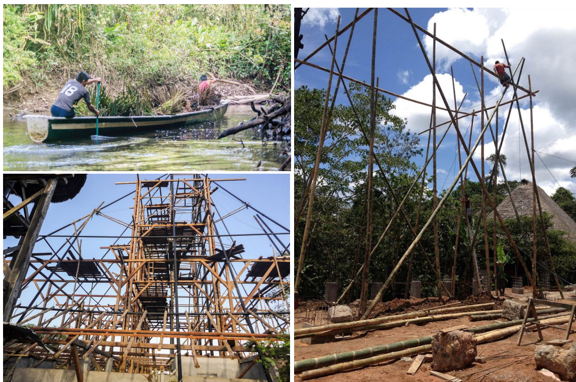
Figura 63. Proceso constructivo de la torre del Napo Wildlife Center.
