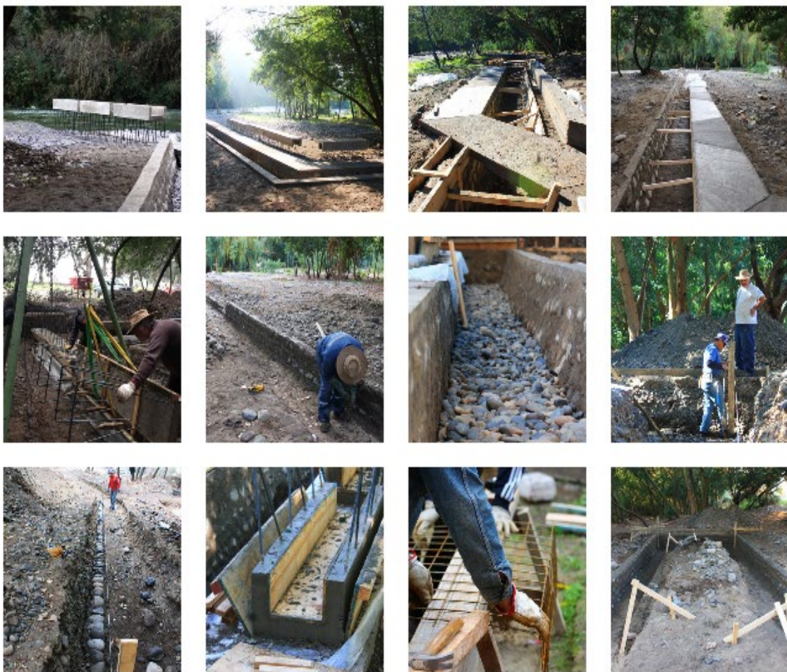
Figura 55. Documentación fotográfica del proceso de construcción de los elementos mencionados. Fuente: ArchDaily, 2014
