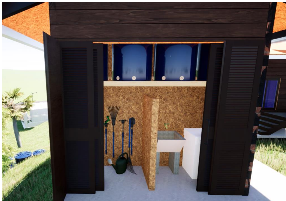
Figura 56. Vista del sistema de recolección de agua lluvia de la vivienda Realizado por: Dalila Galeas
