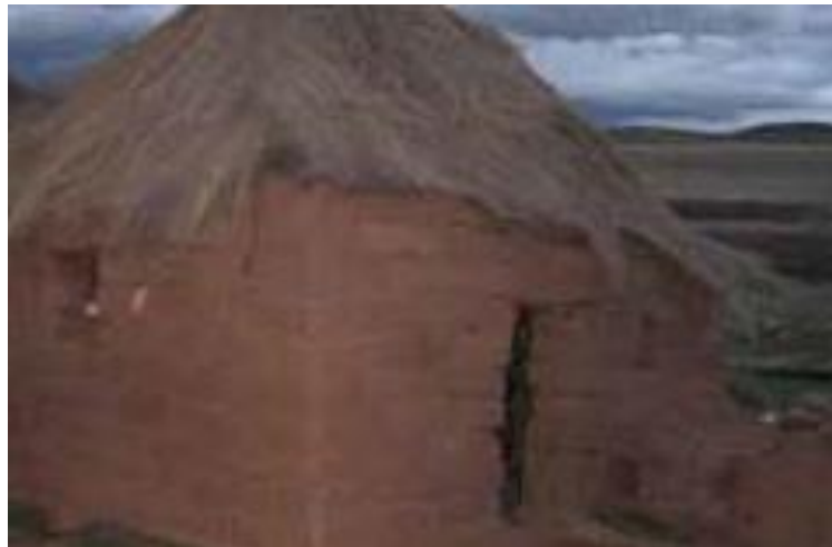
Figura N° 20: Cubierta de paja de la zona, estructura de madera, vivienda rural paramo altoandino Fuente: Proyecto casas abrigadas ADRA
