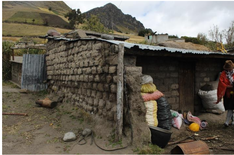
Figura N°4: Vivienda de adobe, cubierta de Zinc, estructura de madera.
