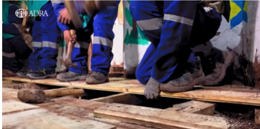
Figura N° 17: Entablado, duelas machiembradas sobre estructura de madera, comunidad de páramo Fuente: Proyecto casas abrigadas ADRA
