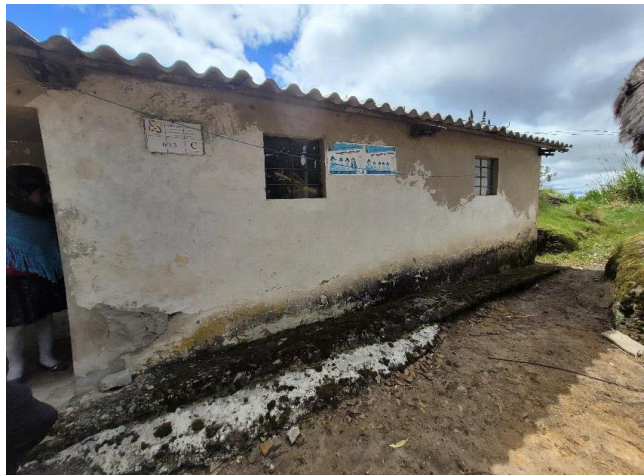
Figura N°7: Exterior vivienda de bloque, con enlucido y cubierta de Zinc, comunidad Talatag. Fuente: Proyecto Vinculación PUCE 2023
