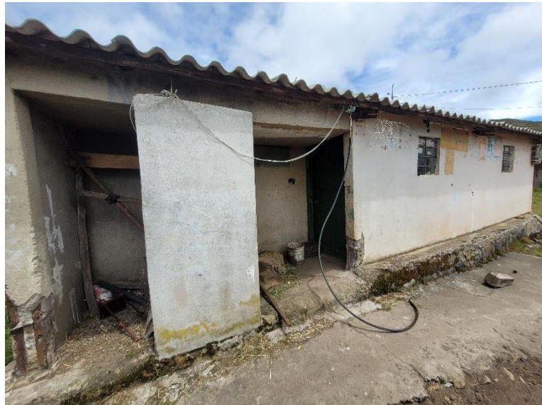
Figura N°3: Vivienda de bloque con enlucido y cubierta de Zinc, comunidad Talatag Fuente: Proyecto Vinculación PUCE 2023
