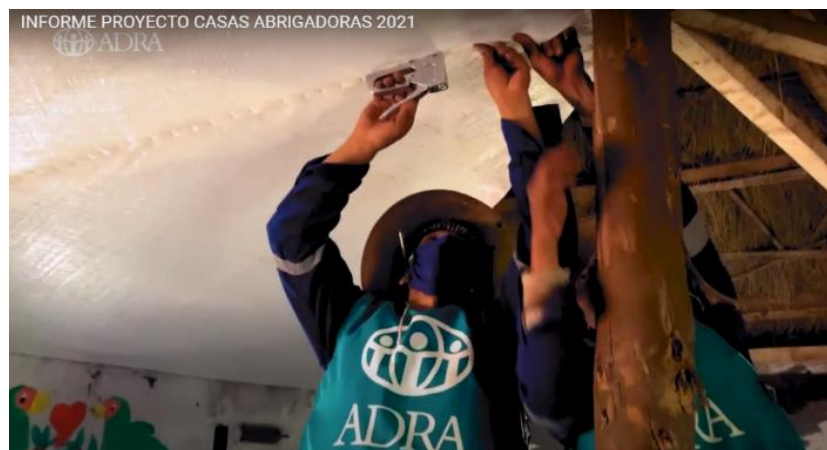
Figura N° 18: Cielo falso con malla tejida, en estructura de madera en comunidad de paramo altoandino. Fuente: Proyecto casas abrigadas ADRA
