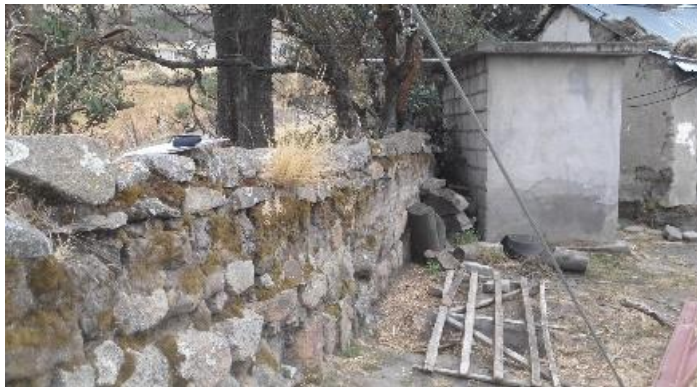
Figura N° 27: Vivienda de la comunidad Talatag, cuenta con muro de piedra.
