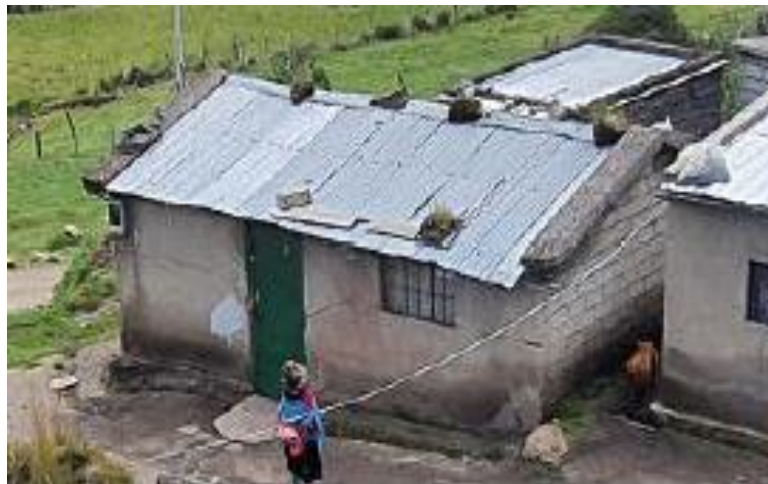
Figura N° 9: Exterior de vivienda de bloque, cubierta de Zinc, en la comunidad Talatag Fuente: Proyecto Vinculación PUCE 2023
