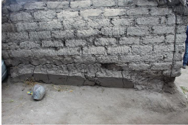
Figura N°6: Exterior Vivienda de adobe, cimientos de tierra, comunidad Talatag Fuente: Proyecto Vinculación PUCE 2023
