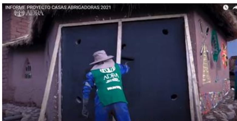
Figura N°14: Proceso constructivo de un Muro Trombe, viviendas en páramos altoandinos
