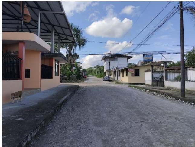
Figura 52. Calle secundaria lastrada en estado medio.
