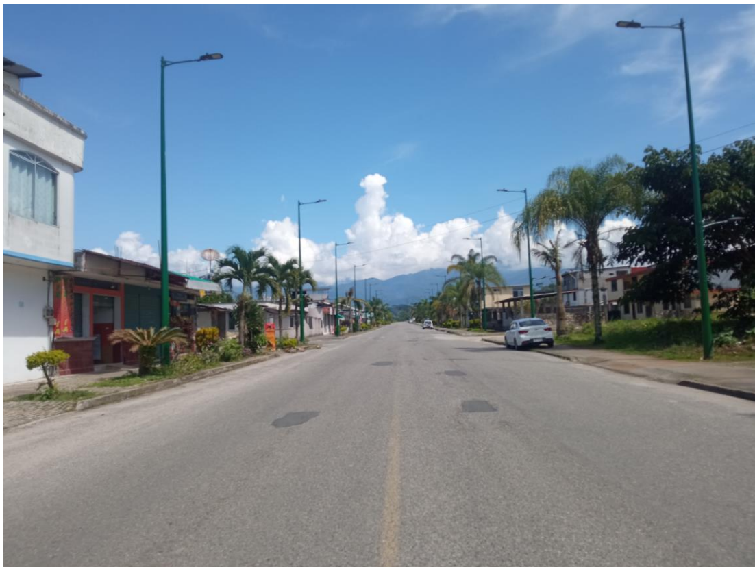
Figura 112. Fotografía actual del punto 2. Realizado por: Sabrina Vargas, 2023.
