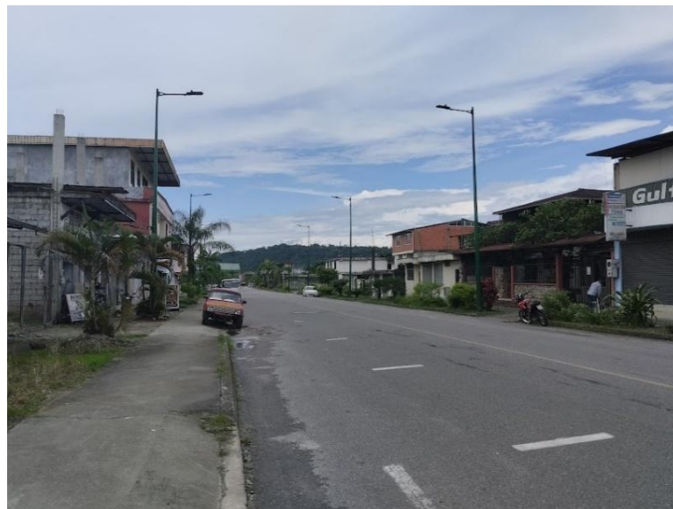
Figura 35. Existencia de infraestructura de vereda en la Av. Tamiahurco.
